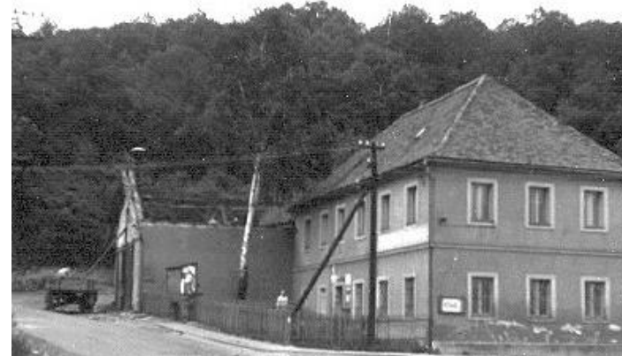
Hasičská zbrojnice a MNV v r. 1974
