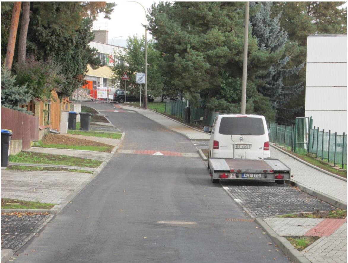
Ulice Nad Školou s novým povrchem a chodníkem
