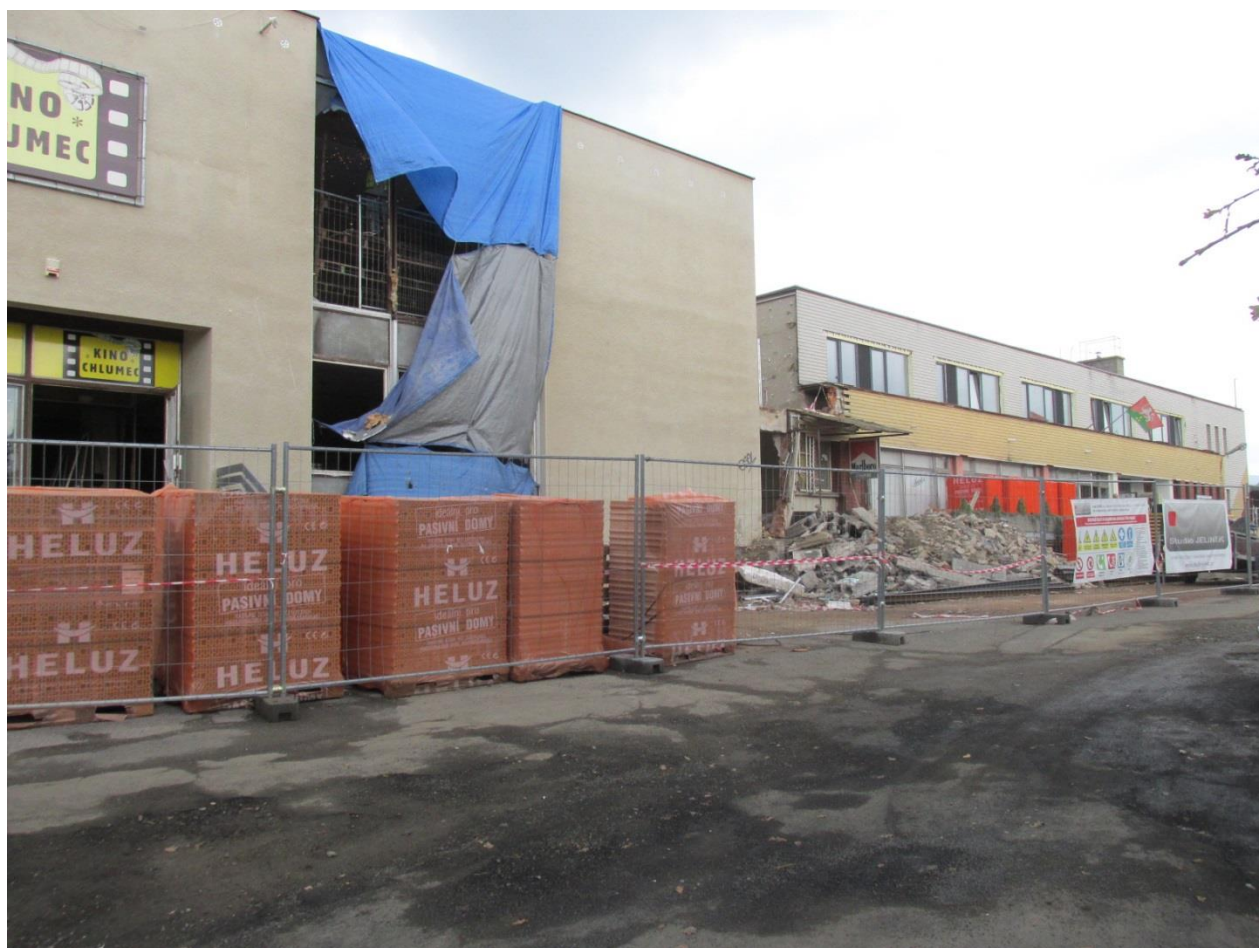
II. etapa rekonstrukce Kulturního domu
