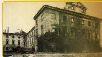
Zámek v demolicí, 1956
