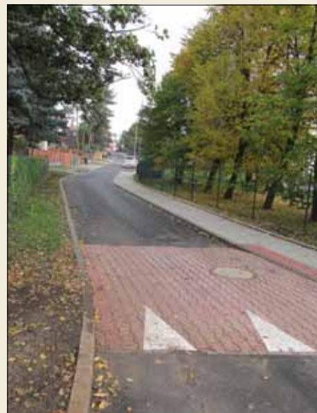
Ul. Nad Školou po rekonstrukci.
