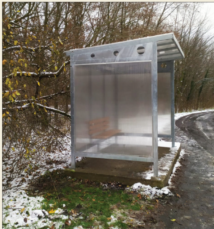
Zastávka Žandov po opravě. Opravu provedli pánové V. Henzl a R. Tojnar.
