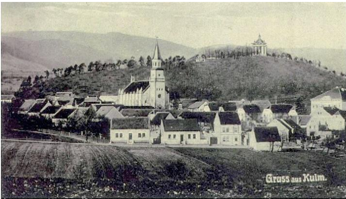
Chlumec v r. 1910 – z čelního pohledu vlevo dům p. Krejčího
