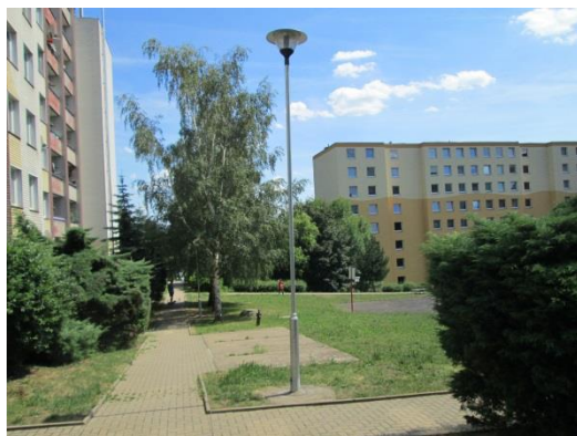
V atriu ve vnitrobloku ulic Zalužanská, Vyklická a Ždírnická bylo v průběhu června vyměněno osm lamp veřejného osvětlení.
