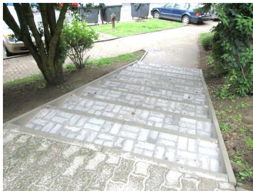
V ul. Zalužanská byla postupně opravena tři schodiště, obrubníky a zámková dlažba.
