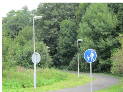
V trase stezky Úžín - Český Újezd bylo obnoveno veřejné osvětlení.
