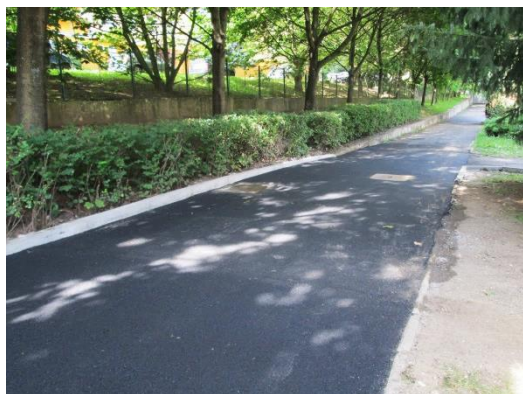
Příjezdová cesta u mateřské školy Pohádka byl opravena, byl zde položen nový povrch a upraveny obrubníky. Opravy provedla firma Marius Pedersen.
