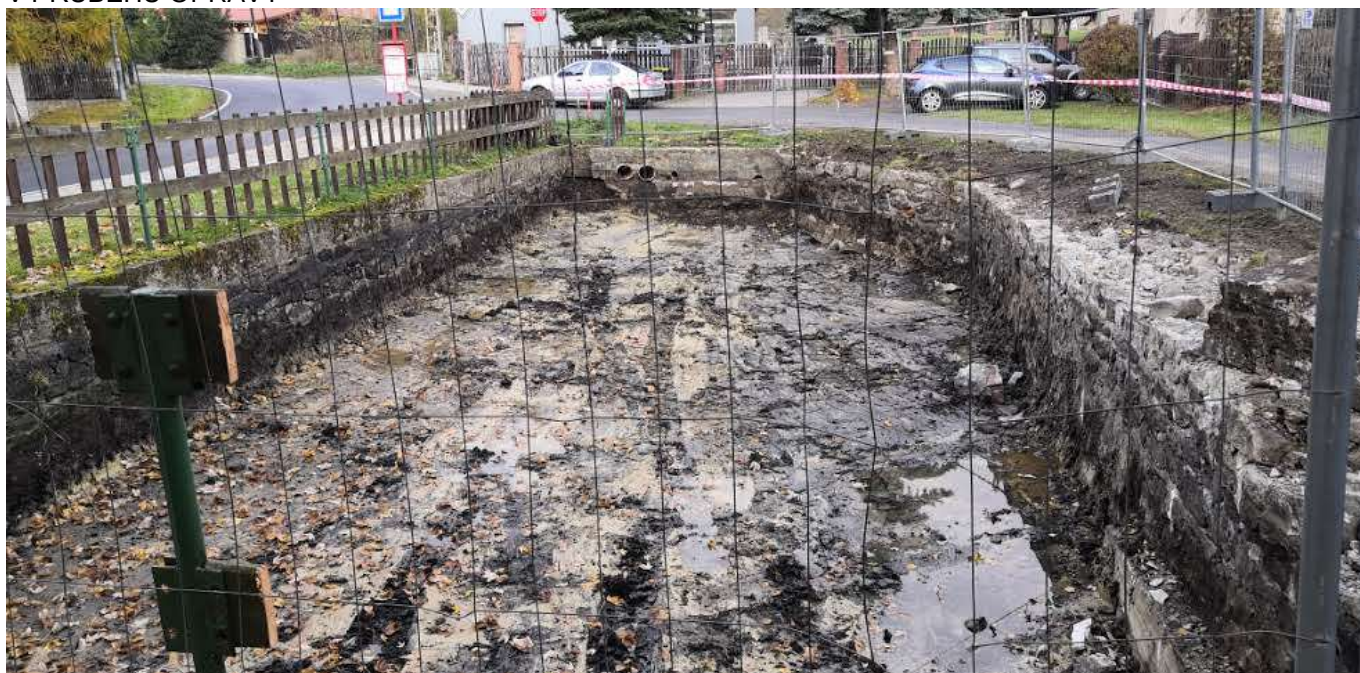
V PRŮBĚHU OPRAVY
